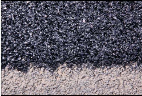
Bild 7: Übergang frisch eingebauter PMA und bereits fertig gestellte Fläche
