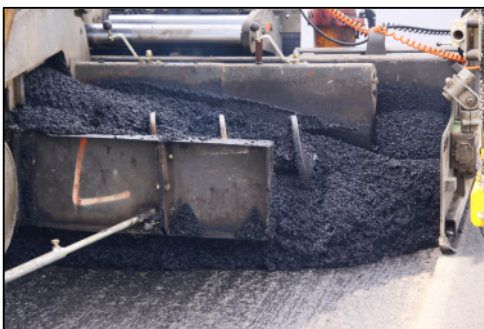
Bild 5: Verteilerschnecke des Fertigers
