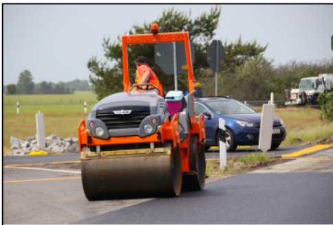
Bild 3: Andrücken der Oberfläche
