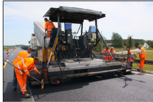
Bild 8: PMA hinter Straßenfertiger
