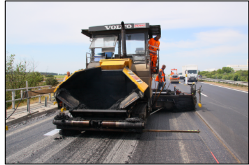
Bild 2: Einbau PMA mittels Straßenfertiger
