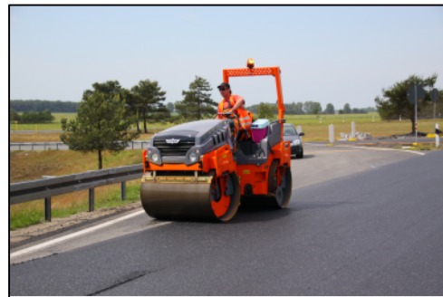
Bild 4: Walzeinsatz in Nahtbereich
