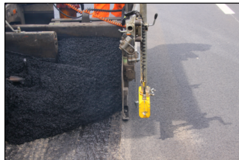
Bild 6: Einbau PMA neben bereits fertig gestellter Fläche
